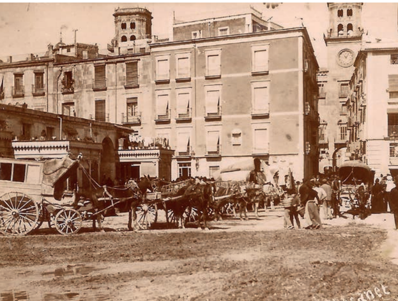
Hacia 1880. Mercado en el lugar que hoy ocupa el Edificio Carbonell
